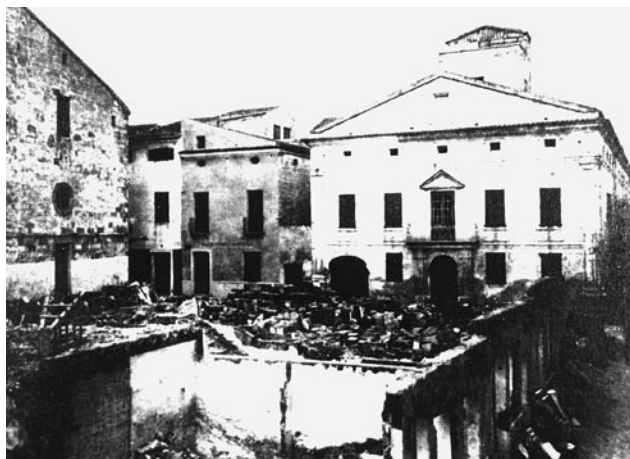
El derrocament de les cases d'es Pont d'es Castell, els anys 50, creà la plaça de la Conquesta i destacà la façana del Palau Ca'n Mercadal, seu de l'arxiu històric.
